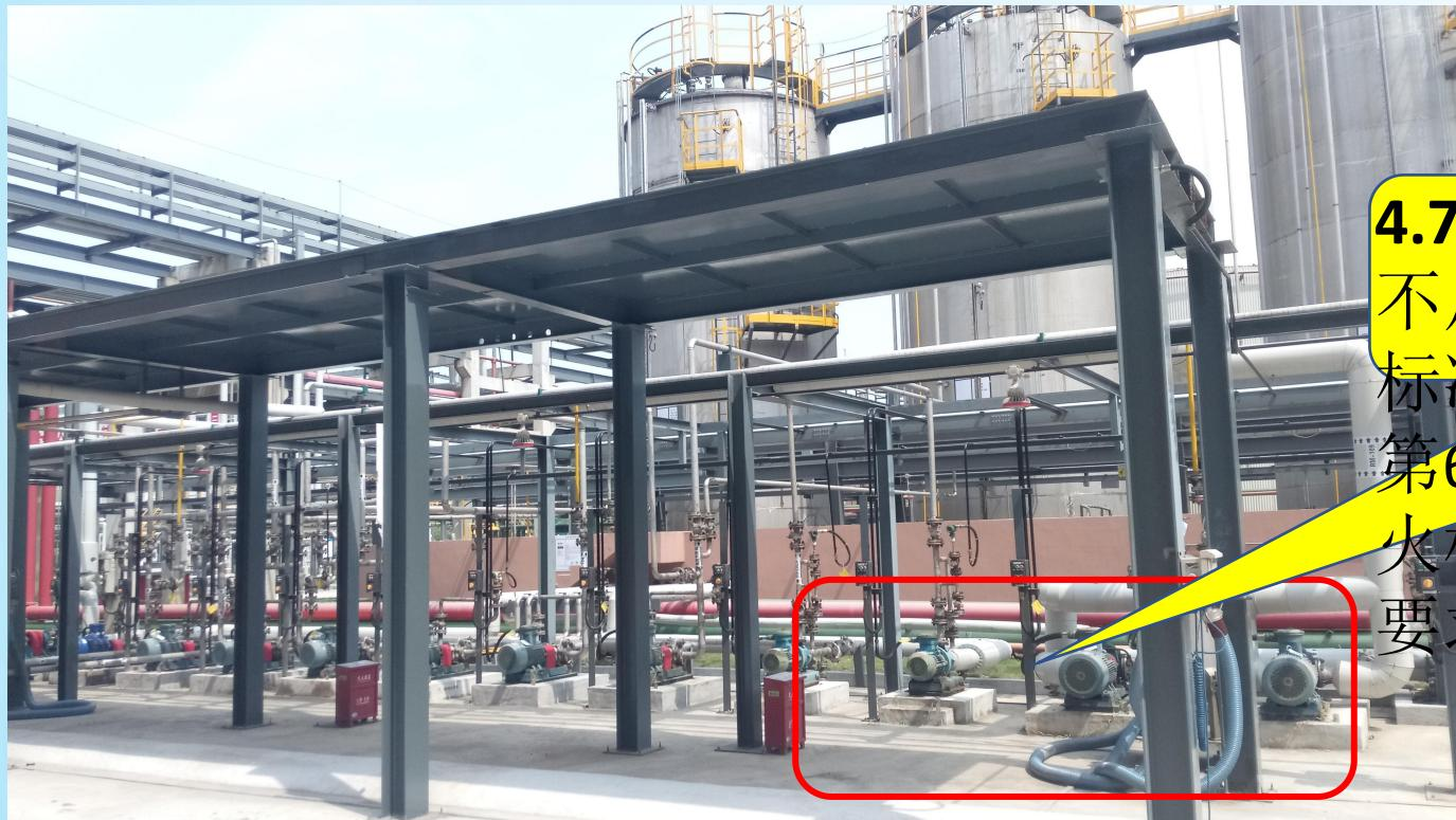
**4.7.7** 丙类罐区T36卸车软管位置和泵距离不足8米，不符合石油化工企业设计防火标准（2018年版）》（GB 50160-2008）第6.4.2条、《精细化工企业工程设计防火标准》（GB 51283-2020）第6.4.1条的要求。
