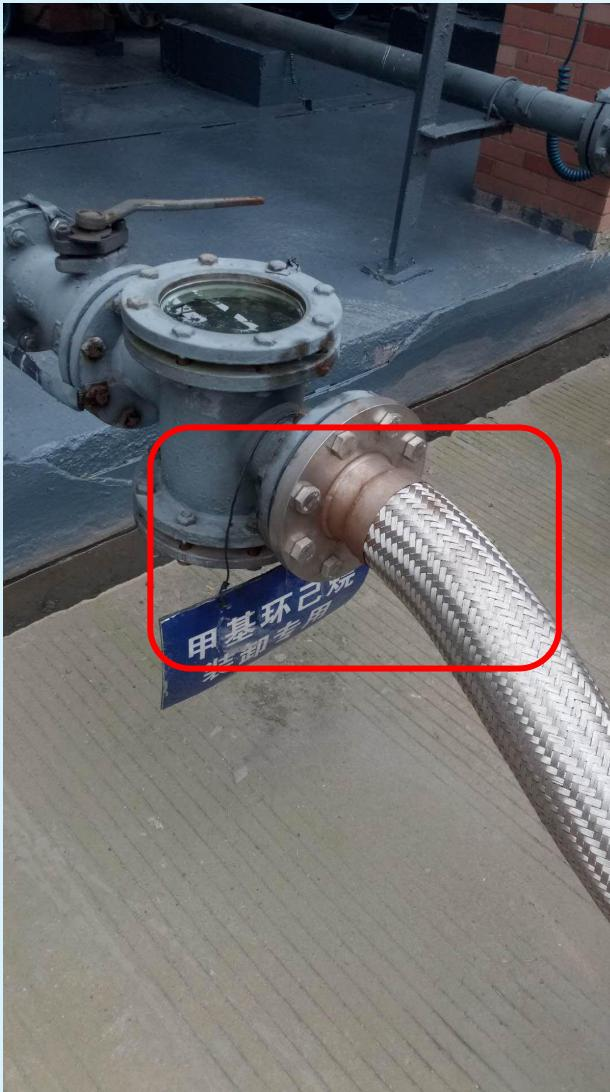
4.7.6 1、T19甲类泵房，甲基环己烷卸料软管中残留液体。2、环氧丙烷卸料安全操作规程中未明确卸料完成后，残液的处置措施；不符合《化工（危险化学品）企业保障生产安全十条规定》（安监总政法〔2017〕15号）的要求。
