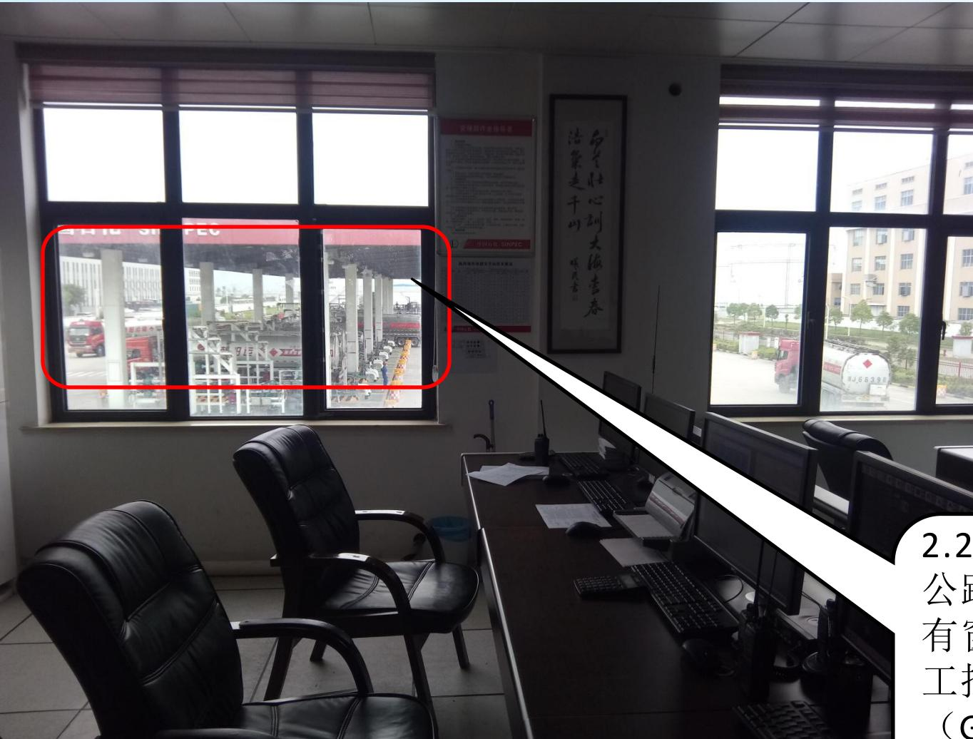
2.2.11 总控制室面向下装公路发油亭（甲类）墙体有窗户，不符合《石油化工控制室抗爆设计规范》（GB 50779-2012）第4.1.4条的要求。
