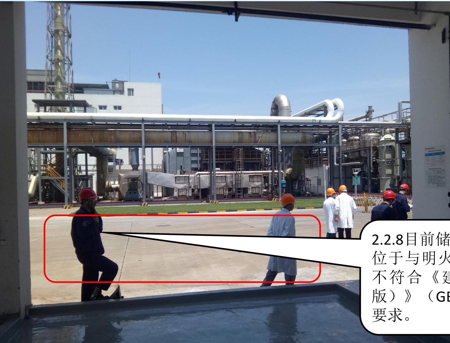
2.2.8 目前储罐区的汽车装卸点未划线，位于与明火点30米的防火间距以内；不符合《建筑设计防火规范（2018版）》（GB 50016-2014）第4.2.1条的要求。
