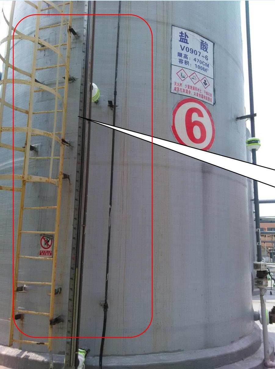
6.3.4 盐酸苯酚罐区、三氯亚磷罐区、成品罐区的高高、低低液位报警共用磁性浮子液位计，缺少单独的液位连续测量仪表或液位开关。
