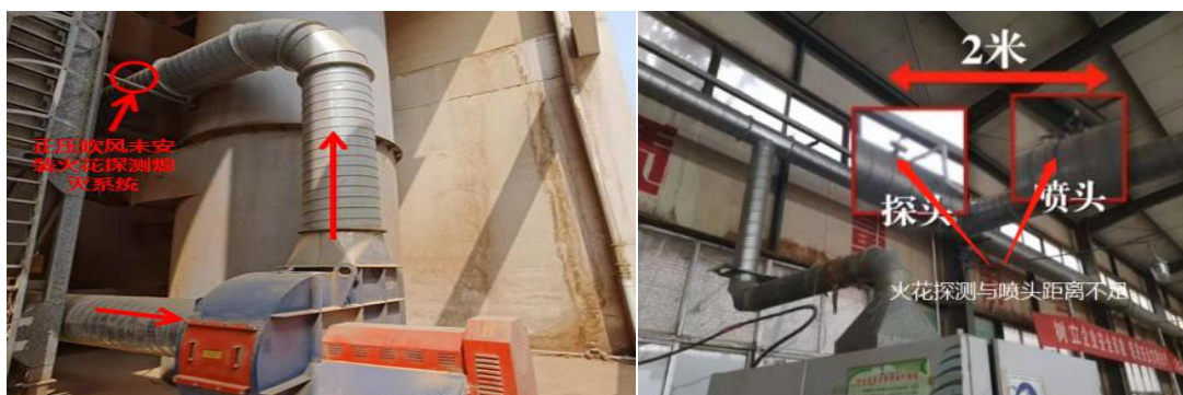
正压吹送未采取防点燃源地措施 (✖) 火花探测与喷头距离不足 (✖)
