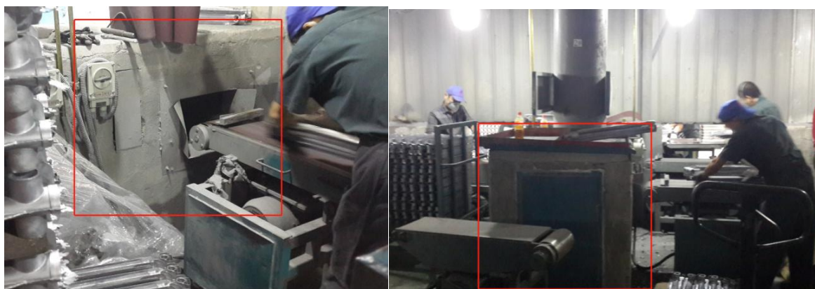
干式巷道式构筑物作为除尘风道（×）
