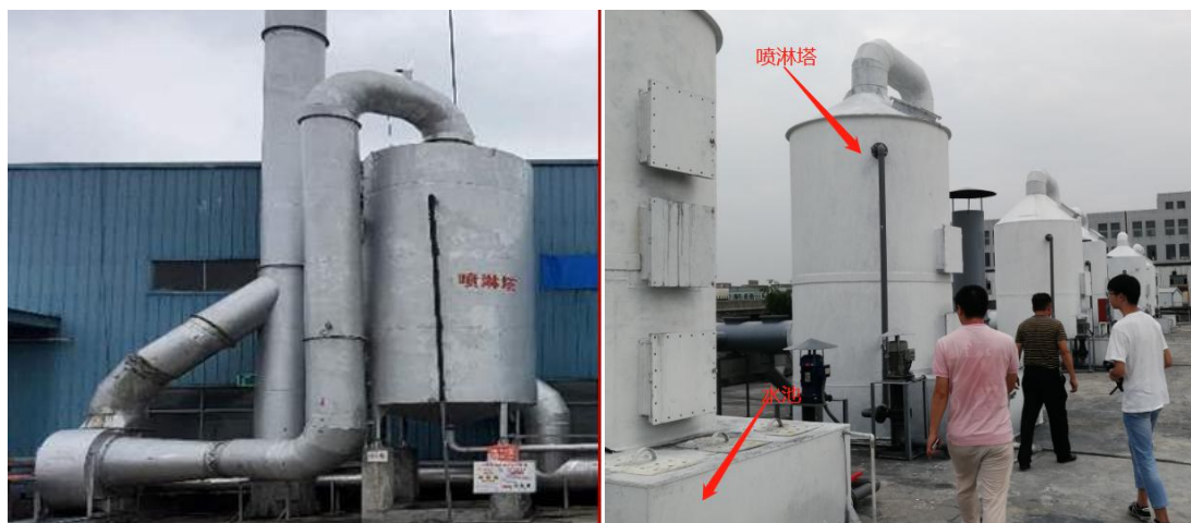
典型湿式集中除尘系统（喷淋塔）
