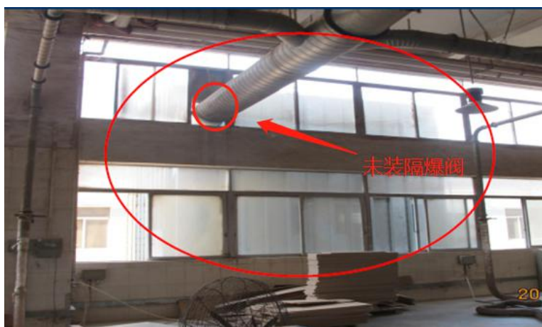
除尘器的进风管直通建筑物内部（✖）
