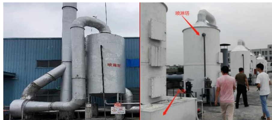
典型湿式集中除尘系统（喷淋塔）
