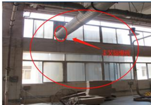
除尘器的进风管直通建筑物内部 (✖)
