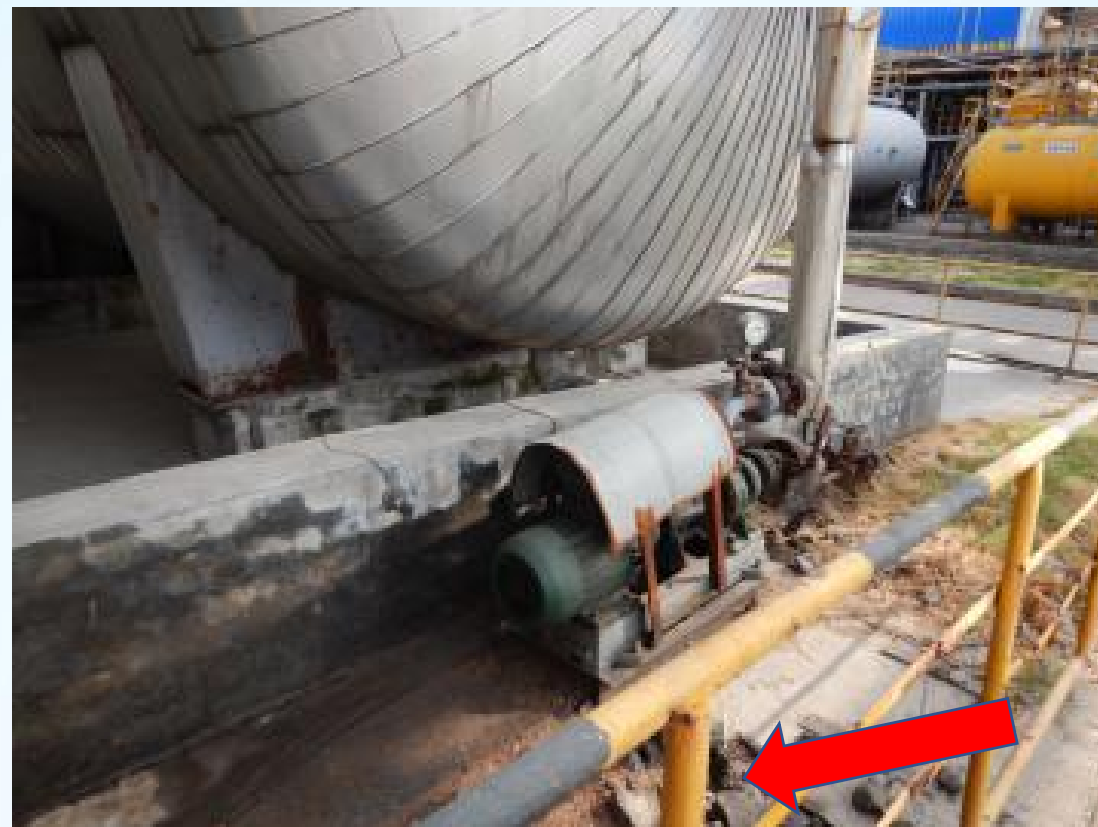
现场NVP（1-乙烯基-2-吡咯烷酮）输送泵周围未设置围堰等防止泄漏液体漫流设施。
