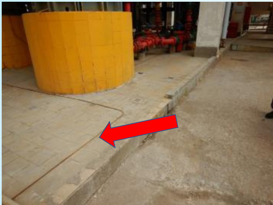
二车间氯甲烷合成工段西侧围堰缺损。
